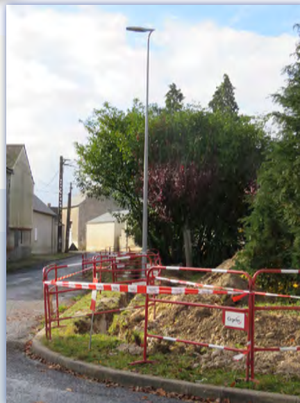
Installation de luminaires pour supprimer des zones de pénombres accidentogènes : devant la pharmacie, rue Saint Pierre à Allainville et hameau d'Epreux
