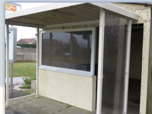
Installation de vitrages à l'abri bus d'Acquebouille pour abriter du vent les écoliers
