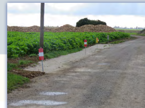
Tranchée drainante à Melleray afin que l'eau ne stagne pas sur la route
